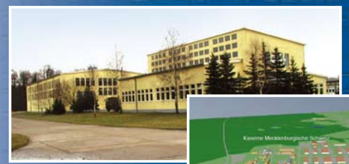
Instandsetzungshalle von Stavenhagen.
