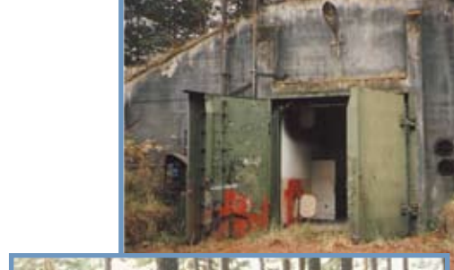
Von ehemaligen Tanklagern gehen große Gefahren für Boden und Grundwasser aus. Ihre Beseitigung erfordert sehr viel Erfahrung.
